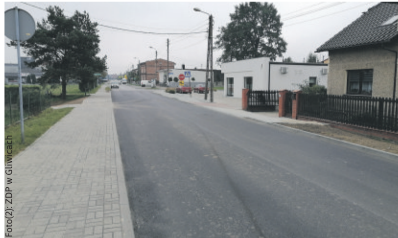
Tak wygląda po remoncie ul. Szkolna w Chudowie.
