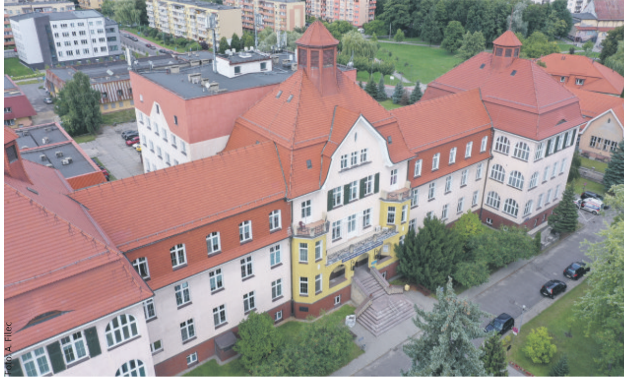
Modernizacja Traktu Porodowego to jeden z licznych remontów, które prowadzone są obecnie w Szpitalu w Knurowie.
