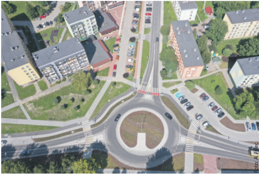
Budowa ronda przy ul. Szpitalnej w Knurowie zwiększyła bezpieczeństwo ruchu drogowego w tym miejscu.
