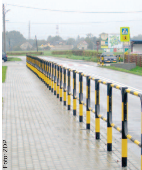
W ub. roku dzięki Inicjatywie Samorządowej wybudowany został m.in. chodnik przy ul. Gliwickiej w Rudzińcu.
