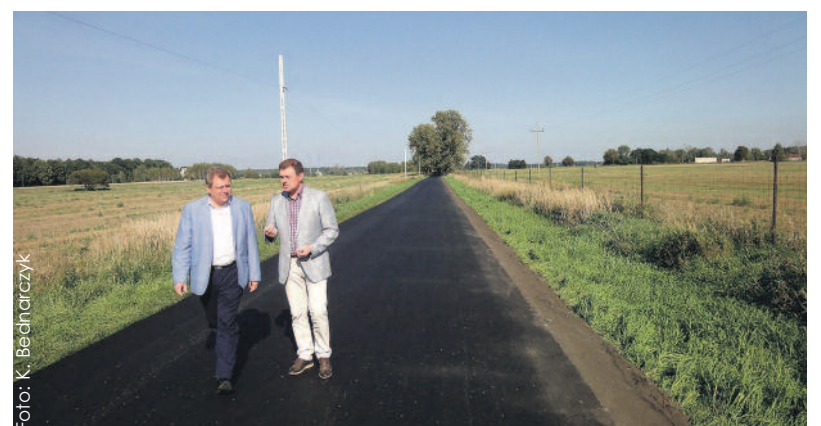
8 września z postępem prac przy remoncie drogi prowadzącej do Łączy zapoznali się starosta Waldemar Dombek i radny Andrzej Frejno.
