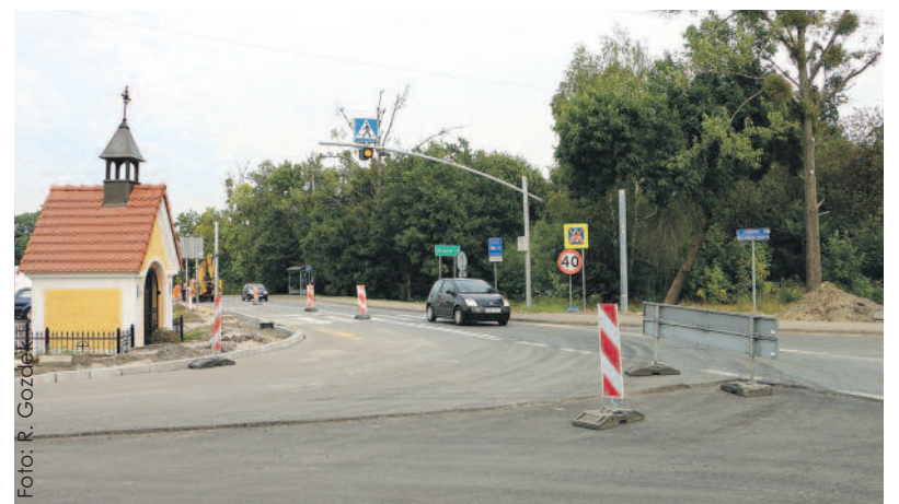
Prace wykonywane są bez zamknięcia ruchu na tym odcinku DK 78, jednak kierowcy muszą się liczyć z utrudnieniami w ruchu.
