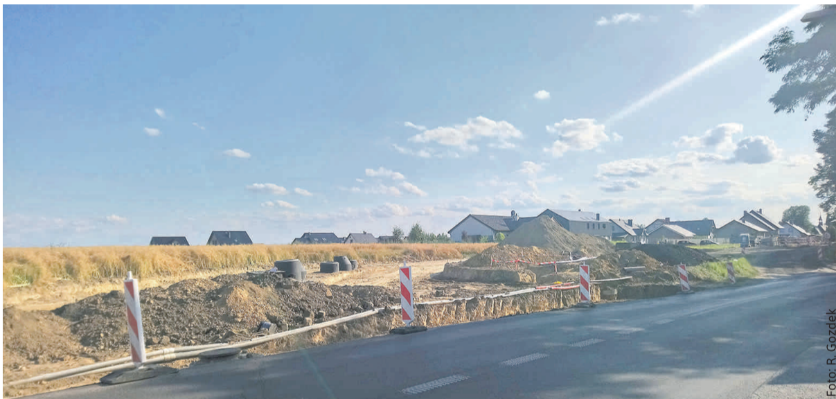
W Żernicy trwa przebudowa uciążliwego dla kierowców połączenia dwóch dróg powiatowych.
