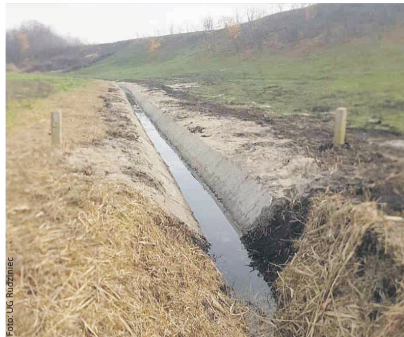
Dobrze dba o urządzenia wodne na swoim terenie m.in. Spółka Wodna Gminy Rudziniec. Na zdjęciu wykonana w ub. roku konserwacja i remont ubezpieczeń skarp oraz dna rowu na kilku działkach w Pławniowicach.
