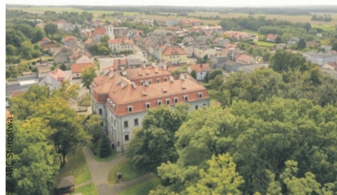
DPS „Ostoja” w Sośnicowicach otrzyma środki na termomodernizację w ramach Polskiego Ładu.
