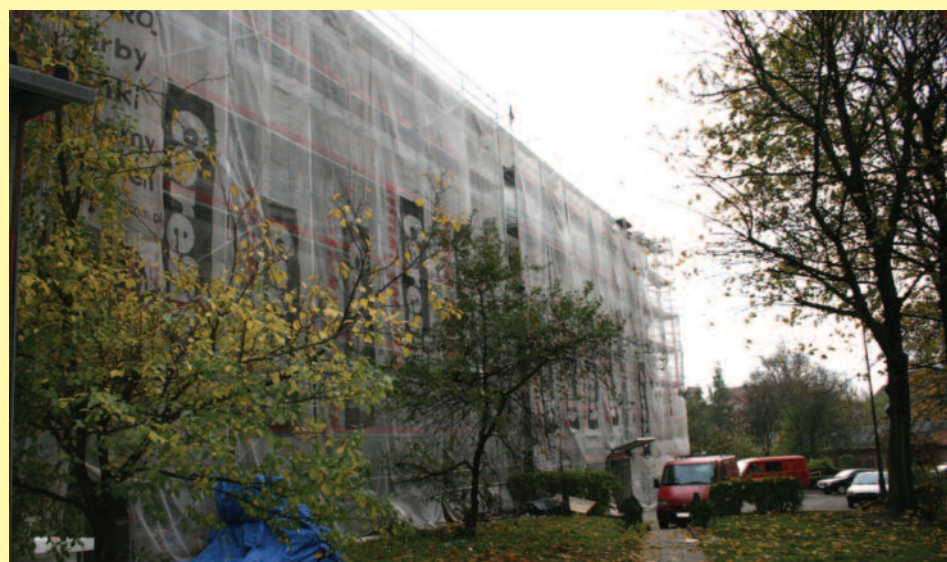
Tak wyglądał szpital w Pyskowicach podczas prac prowadzonych jesienią ub. roku...
