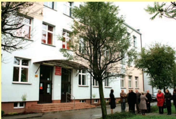
Nowa elewacja Zespołu Szkół Zawodowych nr 2 w Knurowie.
