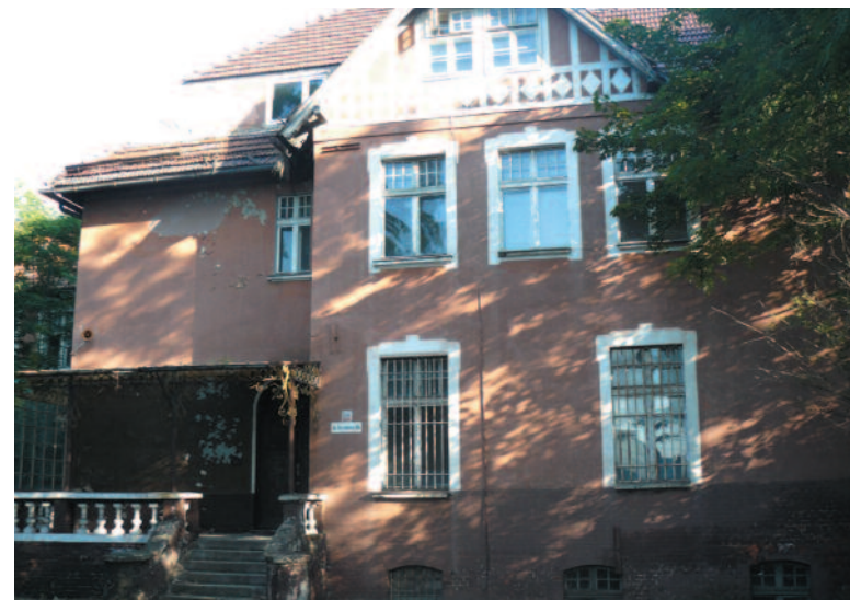
Budynek dawnej dyrekcji fabryki.
