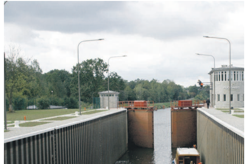
▲ Imponujące wrażenie robi wyremontowana niedawno śluza Rudziniec na Kanale Gliwickim, gdzie różnica poziomów wynosi 6,3 m. Pokonując ją statki stopniowo opuszczają się w dół wraz z obniżającym się poziomem wody w zamkniętej śluzie, potem wypływają poza nią, a śluza jest znowu zamykana i uzupełniana się w niej tony wody.
