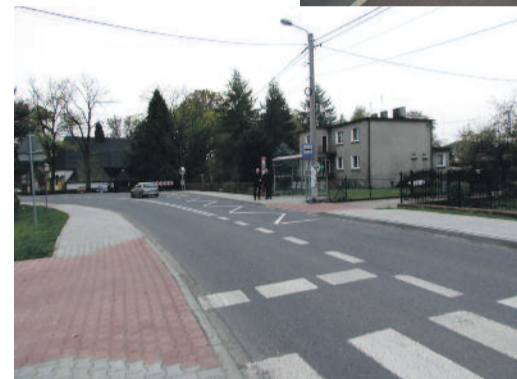
Foto: J. Holc ...a w Rachowicach – nowy chodnik.
