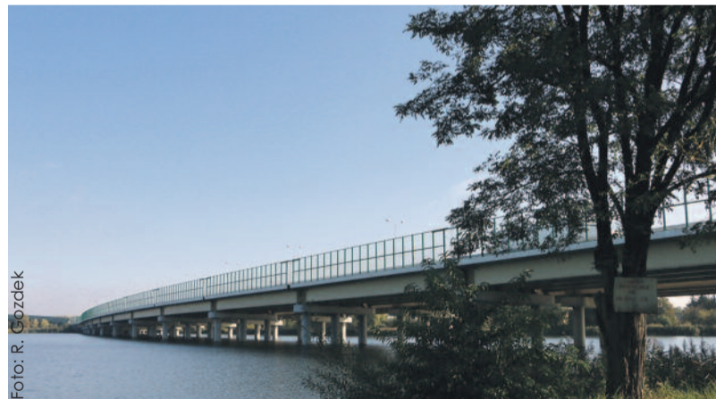
Foto: R. Gozdek Wiadukt nad Moczurami jest nadmiernie hałaśliwy, szczególnie nocą – twierdzą mieszkańcy Knurowa.
