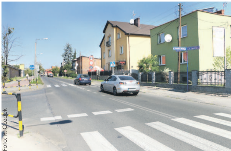
Na skrzyżowaniu z ul. Kazimierza Wielkiego powstanie lewoskręt upłynniający ruch.
