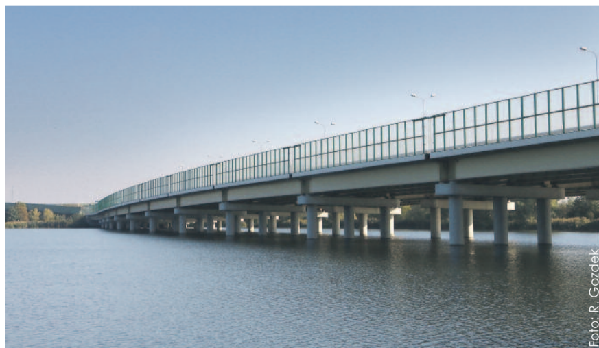
Wiadukt nad Moczurami musi przestać hałasować.
