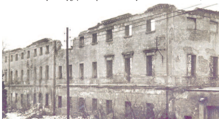
Rosjanie podpalili pałac na początku 1945 r. – potem nadawał się on tylko do rozbiórki.
