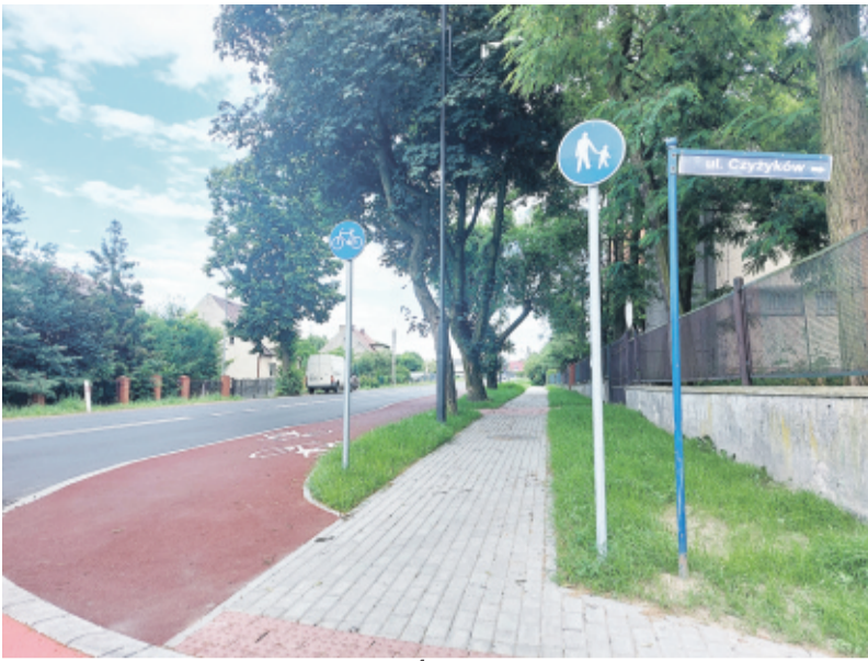
Przebudowana ul. Powstańców Śląskich w Pyskowicach...
