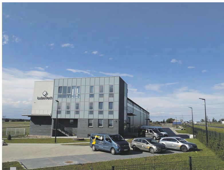
Siedziba firmy LuboTech w Pyskowicach przy ulicy Poznańskiej 15
