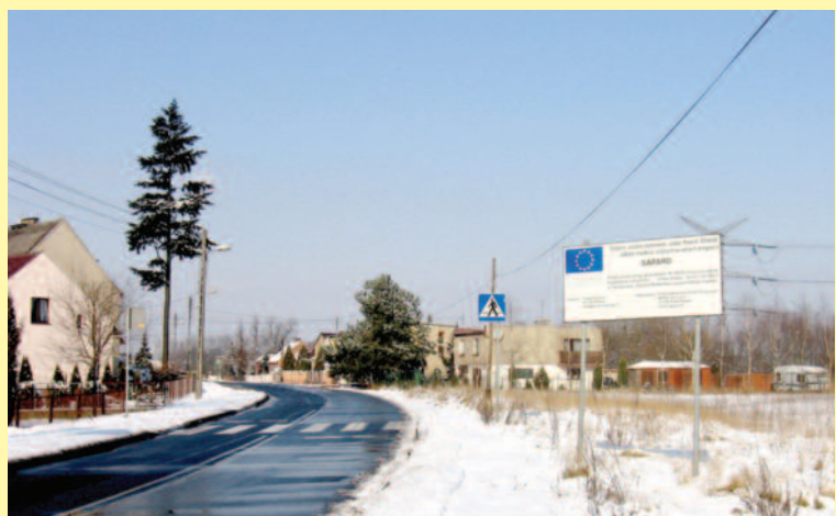
« Droga powiatowa w Taciszowie po przebudowie.
