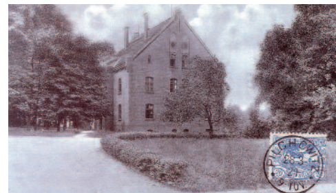
W niezmienionej postaci zachował się natomiast budynek dawnej szkoły, obecnie remontowany.
