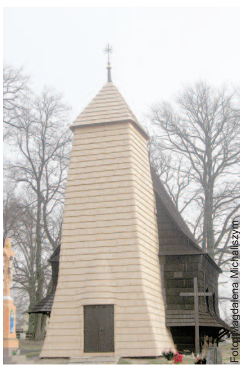
Wyremontowana wieża drewnianego kościołka w Zacharzewicach.
