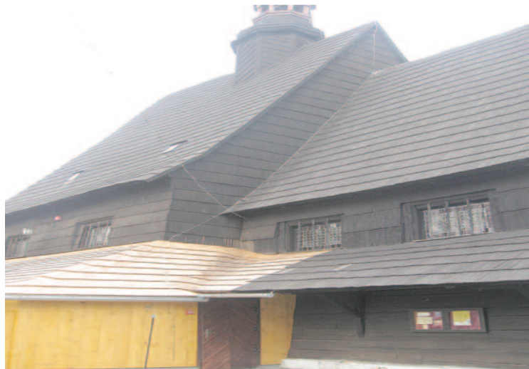
Powiat Gliwicki wsparł też remont modrzewiowego kościółka w Poniszowicach...
