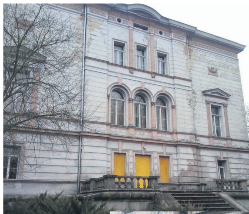
Może znajdzie się inwestor, który ocali ten niszczący obiekt?
