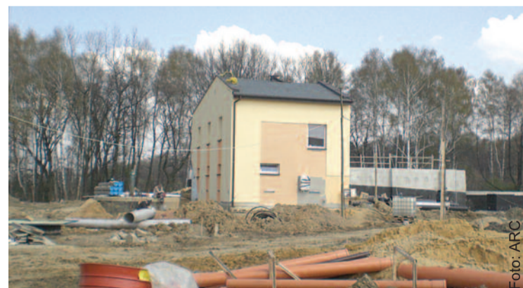
Prace na budowie idą pełną parą.
