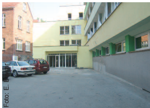
Między starą i nową częścią szpitala powstał już łącznik. Ta potrzebna inwestycja, umożliwiająca dalszą modernizację placówki, została sfinansowana przez powiat.
