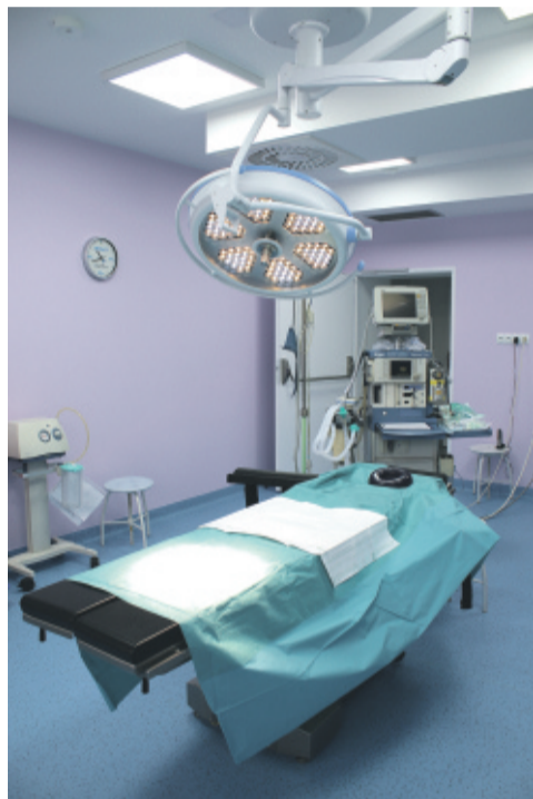
Zmodernizowany blok operacyjny.
