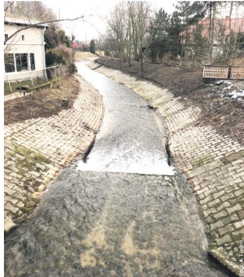
Potok Toszecki w Niewiesz, przy ujściu do jeziora Pławniowice – po konserwacji nie zalewa i nie podmywa już pobliskich domostw i pól.
