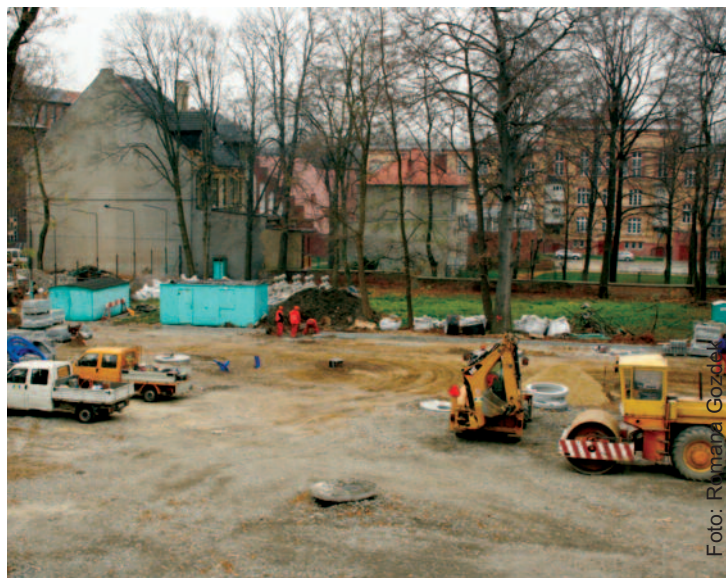
Parking na tyłach starostwa zamienił się niemalże w plac budowy.
