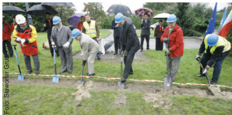
Wbicie pierwszych łopat rozpoczęło latem ub. r. budowę nowoczesnej sieci kanalizacyjnej w gminie Gierałtowice.
