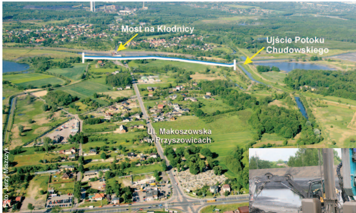
Przebieg nowego obwałowania zaznaczony na zdjęciu wykonanym z lotu ptaka.
