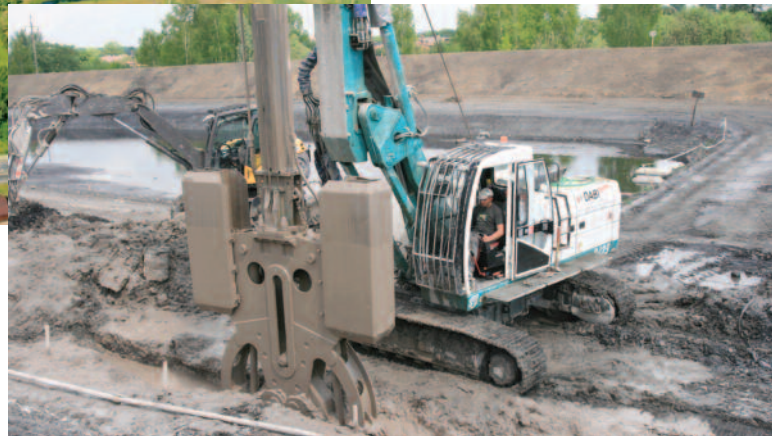
Przy budowie przesłony pracowała m.in. Casagranda – potężna maszyna, która wykonuje takie zabezpieczenia do 28 metrów w głąb ziemi.
