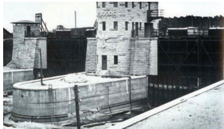
Budowa śluzy Neudorf (Nowa Wieś) na Kanale Gliwickim (oba zdjęcia pochodzą z omawianej książki).
