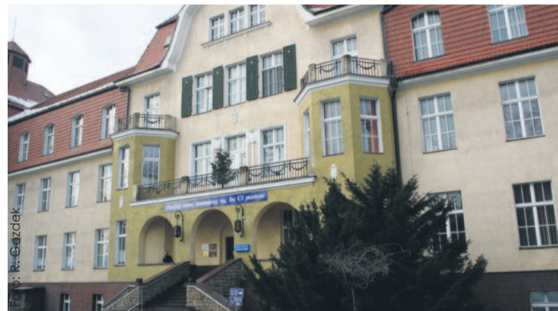
W budynku głównym Szpitala w Knurowie wymieniona zostanie stolarka okienna.
