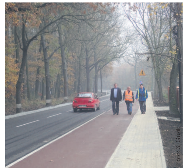
Przy modernizowanym odcinku drogi powstał wygodny chodnik i ścieżka rowerowa.
