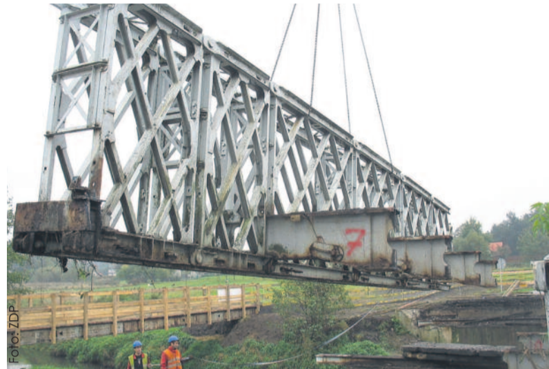
Moment usuwania konstrukcji starego mostu w Leboszowicach.
