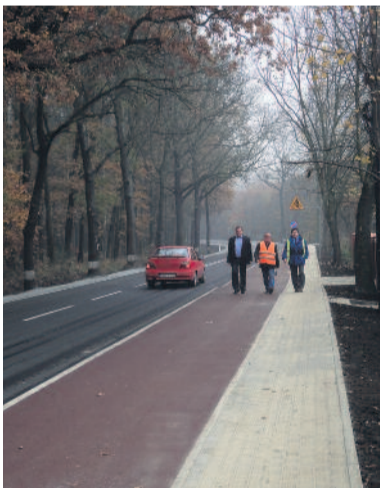
Przy wyremontowanym odcinku drogi Żernica-Smolnica jest wygodny chodnik i ścieżka rowerowa.
