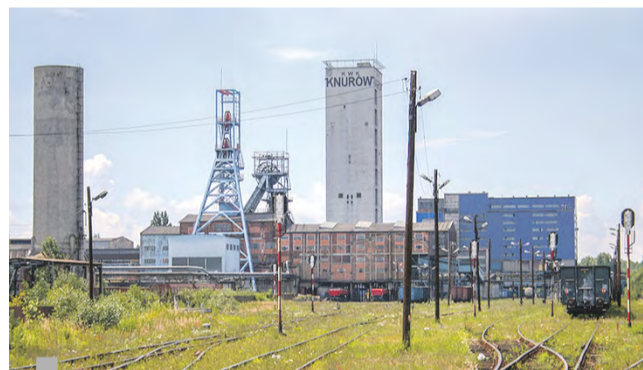
KWK Knurów. Szyby Paweł - po lewej rozebrany już, Piotr - w środku z napędem parowym i Jan - po prawej.
