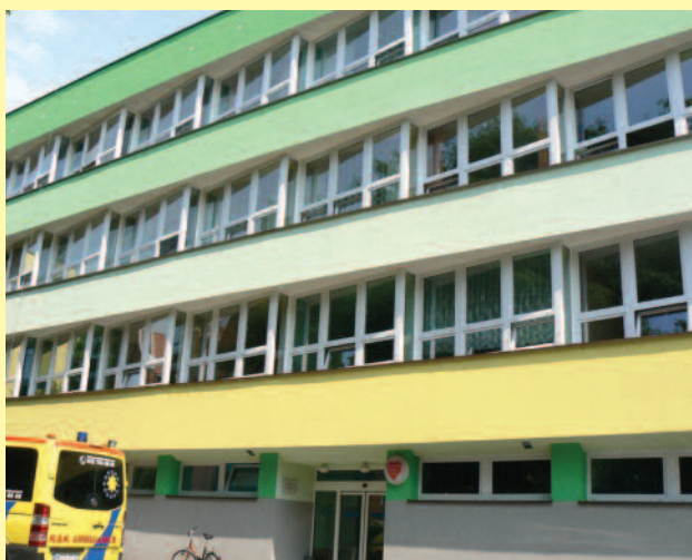
Powiat inwestował w remont budynków. Na zdjęciu nowa elewacja Szpitala Powiatowego w Pyskowicach.
