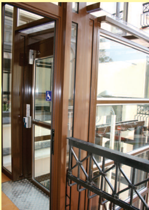
Przełamano bariery architektoniczne – Starostwo Powiatowe zostało wyposażone w windę dla osób niepełnosprawnych.
