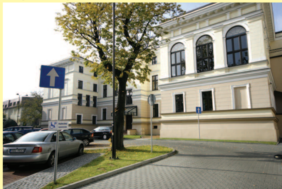
W minionej kadencji dokończona została termomodernizacja budynku starostwa, wyremontowano także parking.
