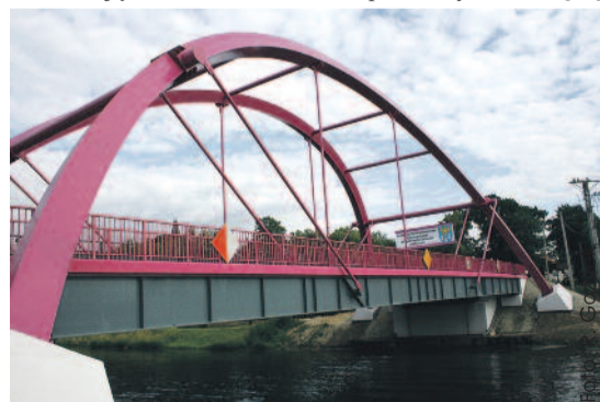
Jedną z największych inwestycji Powiatu Gliwickiego, zrealizowaną dzięki unijnemu wsparciu, jest modernizacja mostu w Pławniowicach.
