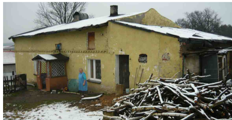
Stary budynek przed rozpoczęciem robót.
