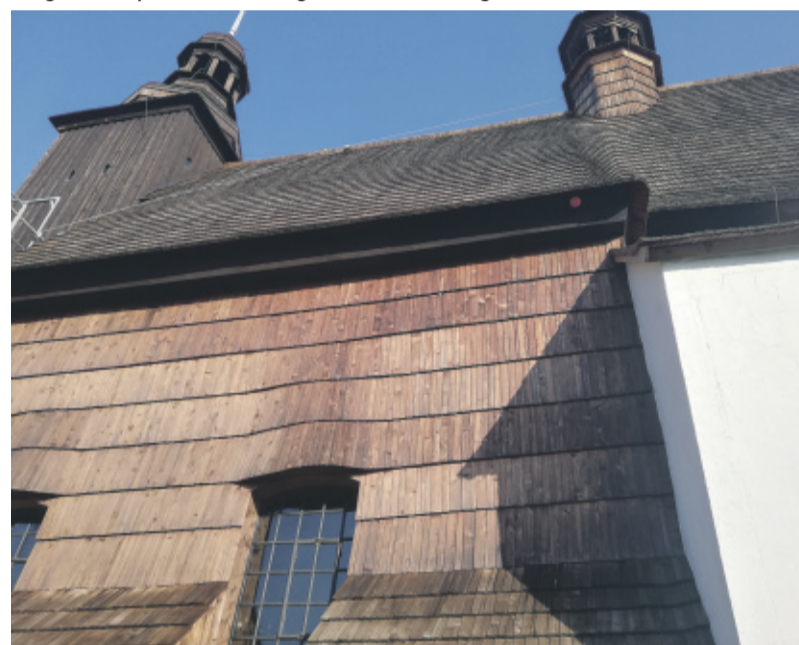
W kościele w Sierotach konserwacji poddane zostały drewniane gonty.
