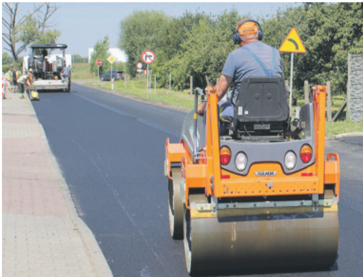
Naprawa drogi powiatowej przy ul. Korfantego w Gierałtowicach.
