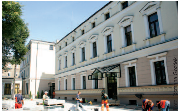
W trakcie prac na parkingu przed starostwem.
