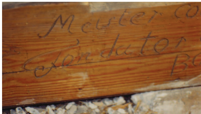
Fragment starej belki stropowej odnalezioniej w kamienicy przy pyskowickim Rynku.
