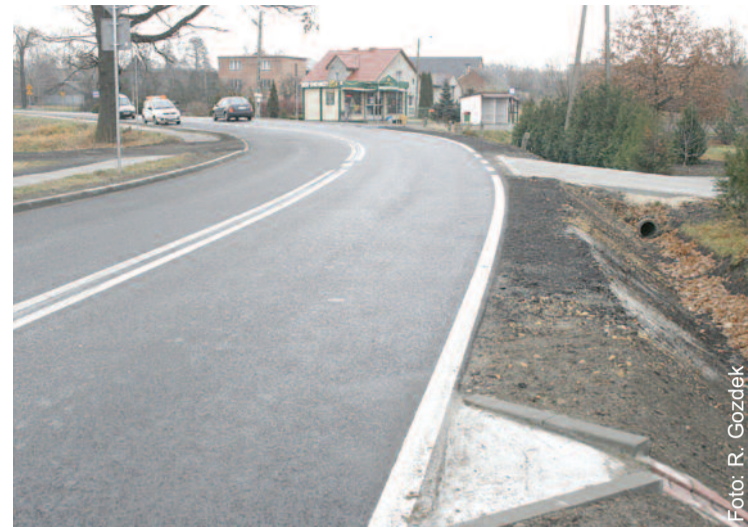
W ub. roku wykonana została modernizacja drogi Łany Wielkie-Kozłów, teraz planowane są kolejne.
