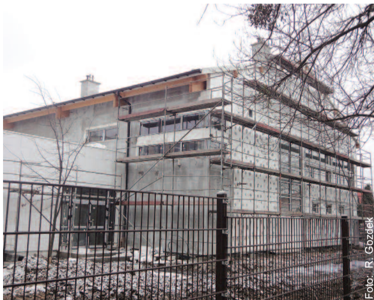
Tak wygląda będąca obecnie w budowie hala sportowa przy Zespole Szkół im. I. J. Paderewskiego w Knurowie...
