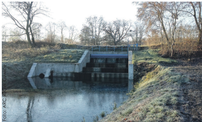
Jeden z wyremontowanych jazów na Kanale Gliwickim.
