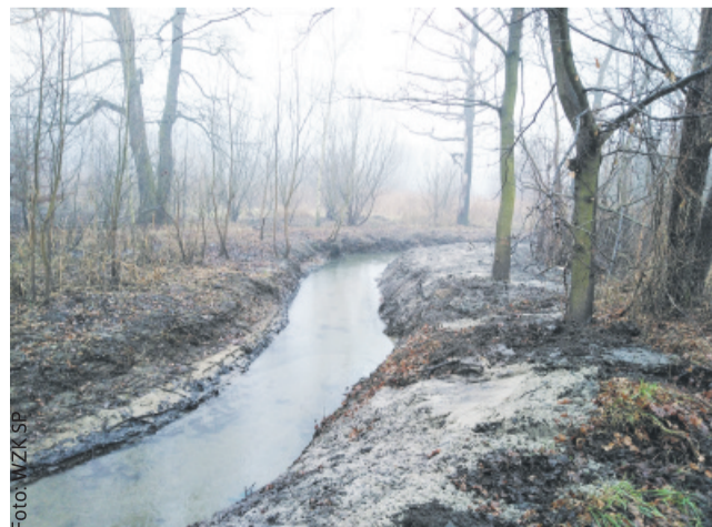
Koryto potoku Ormontowickiego przy ujściu do potoku Chudowskiego tuż po wykonaniu prac.
